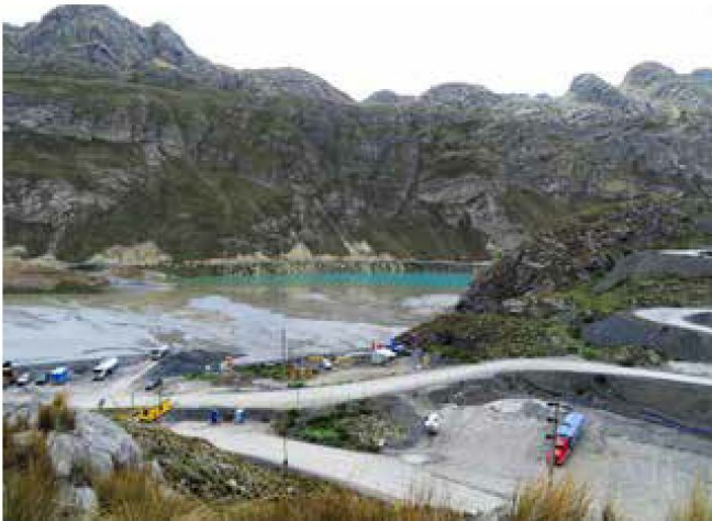
Güney Amerika'daki bir atık barajı
