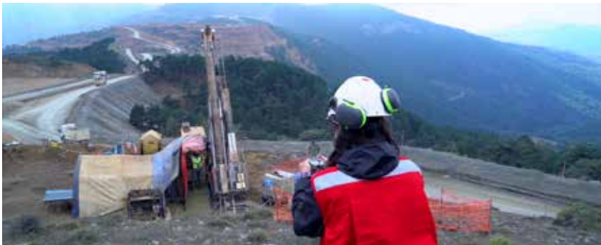
Maden Arama - Karotlu Sondaj
