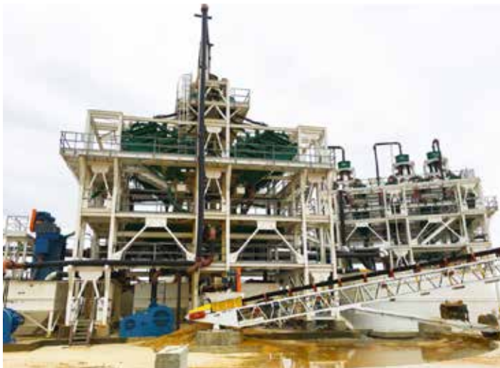
Şekil 1: ABD, Arkansas'taki Çatlatma Kum Üretim Tesisi
